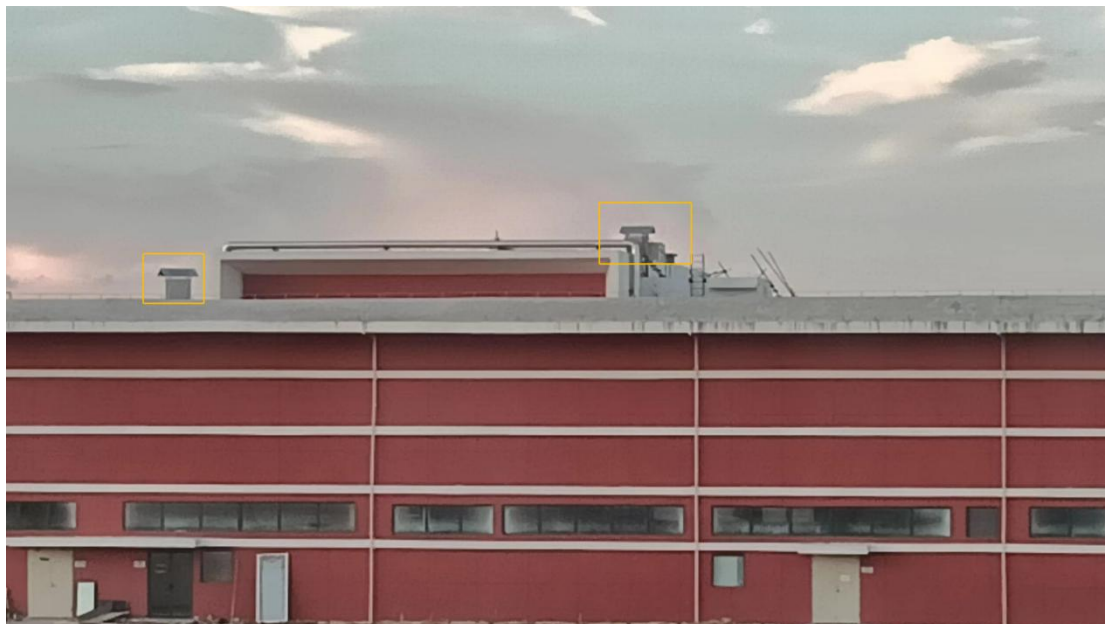
图 5-60HIAF 隧道排风口照片
