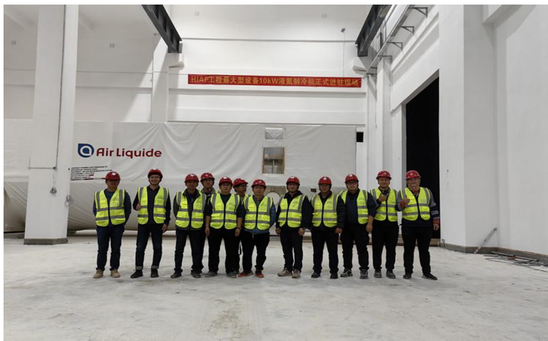
图 4.4 10kW 液氮制冷机安装就位
