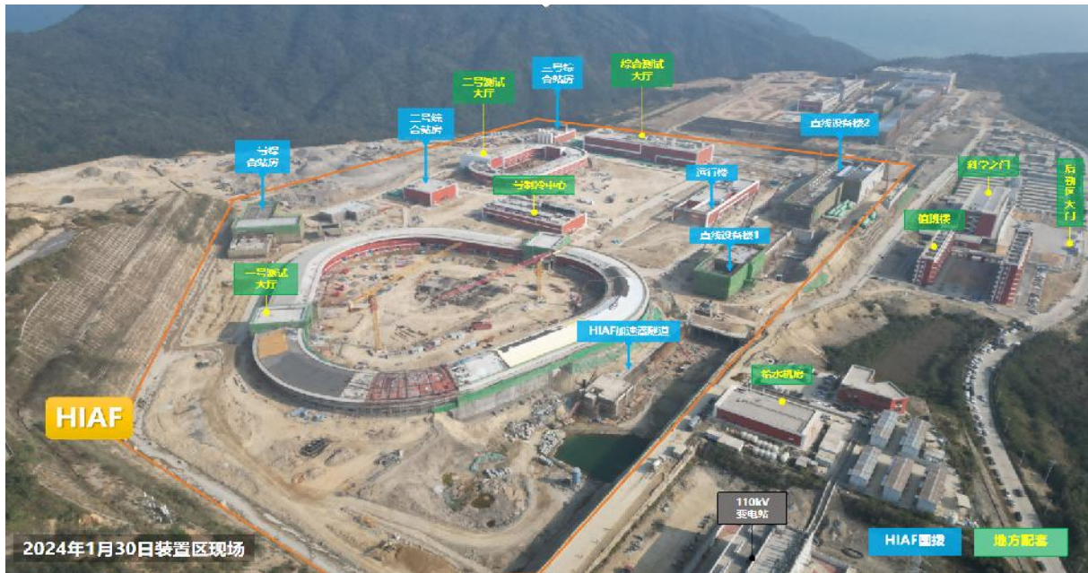
图 2.13 HIAF 装置区航拍图（2024 年 1 月 30 日）
