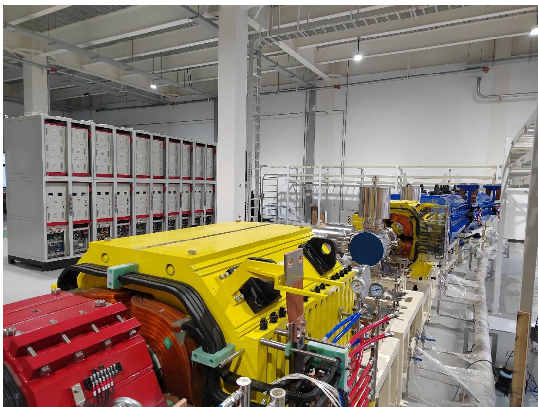
图 2.21 HIAF-BRing 弧区样段安装现场
