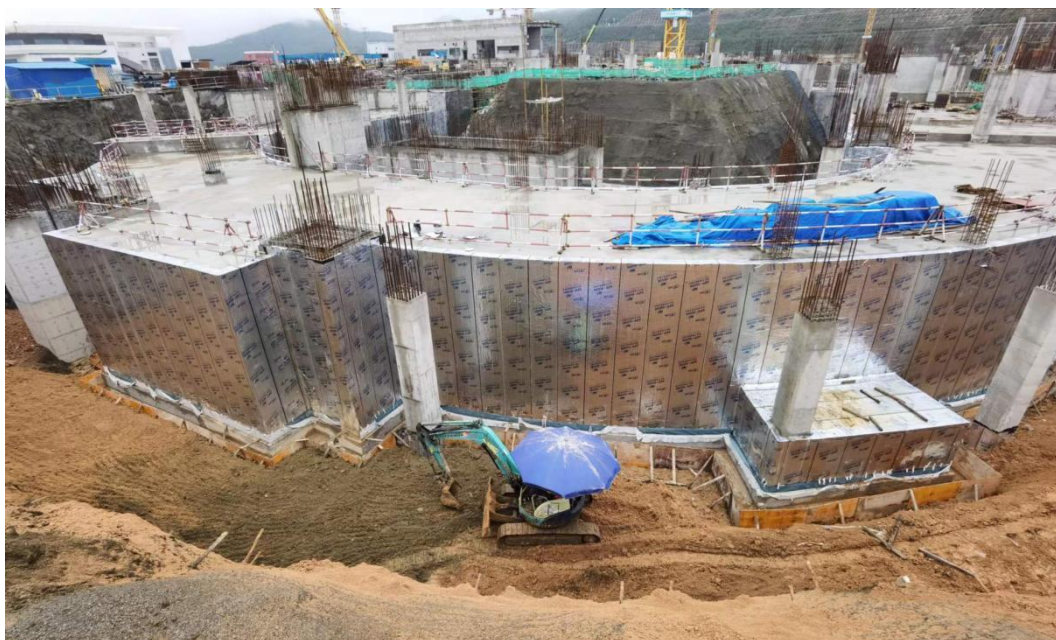
图 2.26 HIAF-SRing 加速器隧道回填
