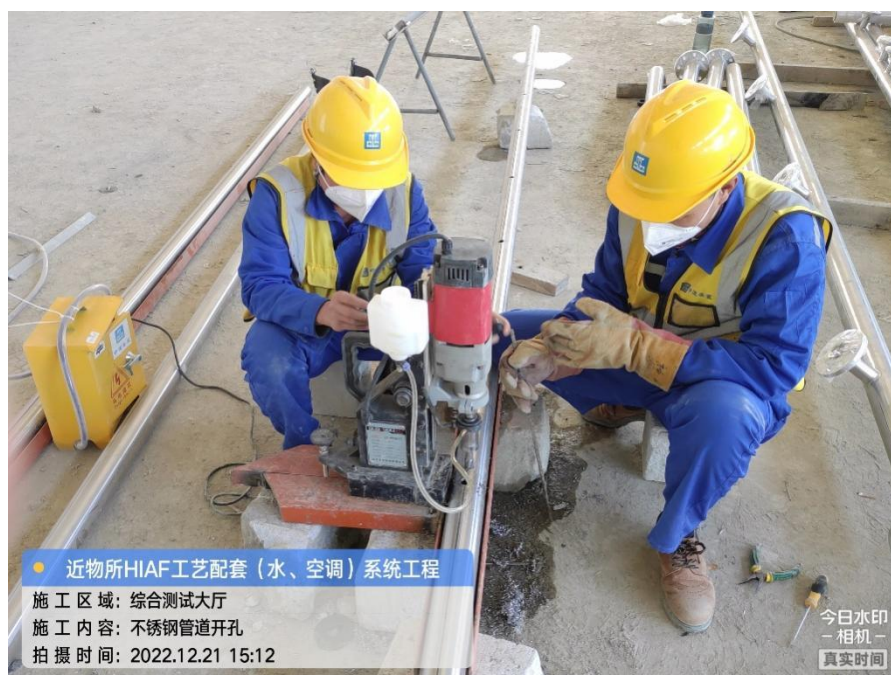
图 2.29 HIAF 综合测试大厅工艺配套系统安装
