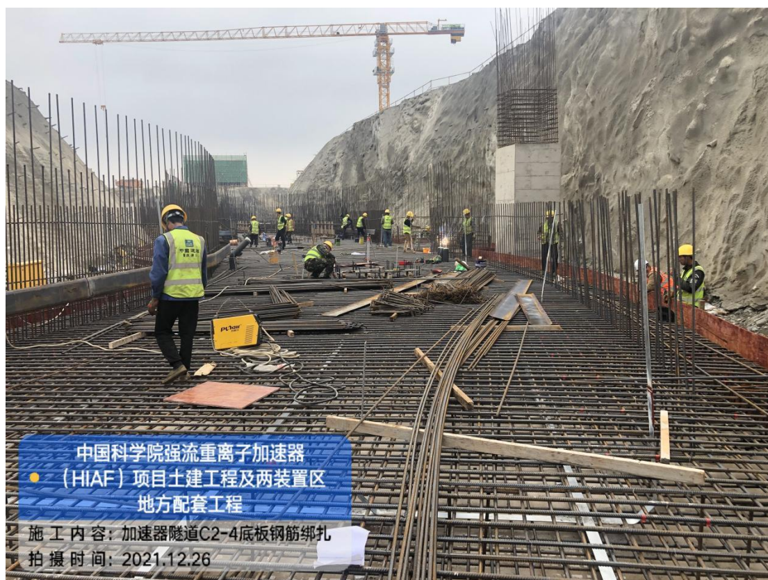
图 2.29 HIAF 加速器隧道底板钢筋绑扎
