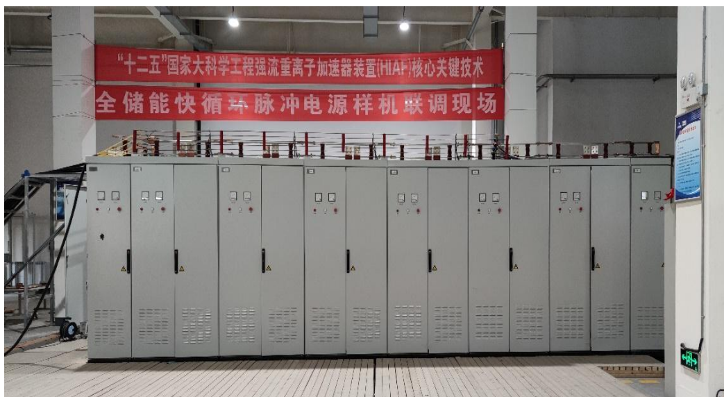
图 2.4 全储能快循环脉冲电源样机
