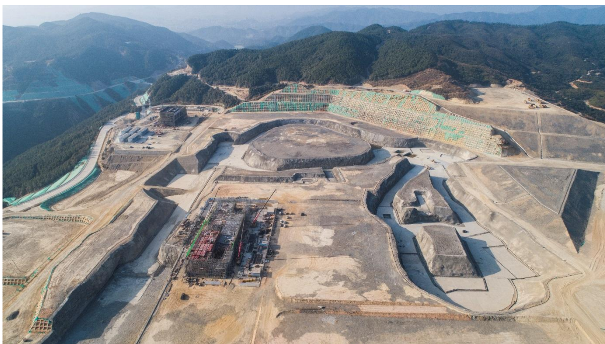
图 2.14 HIAF 园区土建施工现场
