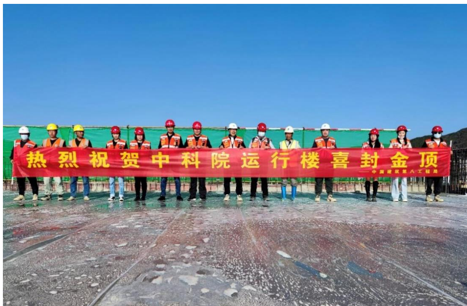
图 2.15 HIAF 运行楼结构封顶
